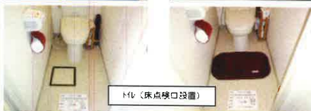
洗面（床開口・復旧）
